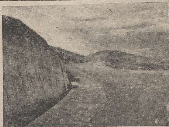
Carreteras de esta clase demanda el país para su progreso y los choferes para su seguridad. Es un tramo de la carretera Latacunga-Quevedo, cerca del páramo de Millín.
