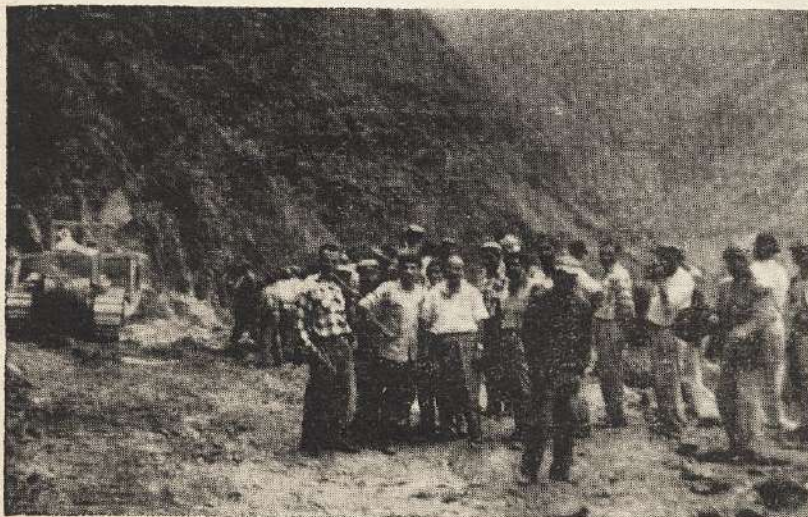
En lamentable estado se encuentra el tramo de la carretera Latacunga-Quevedo en el sector de El Guango.
